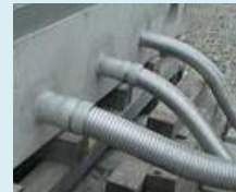
引込用管路 【ステンレス可とう管(EP)】 【継手付防砂管】
