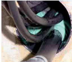
③ストップを100mm注入。ケーブル間の隙間をとり充填する
