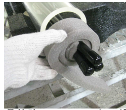
①管路口150mm先スポンジを詰める
