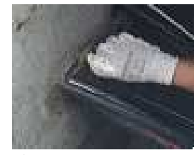
④難燃モルタルを管路口まで50mm詰める
