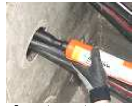
②ストップ先端に注入ノズルを付ける
