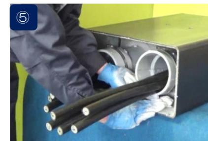
DSモルタルをCRKの周りに200mm厚さで充填します。CRKが開口の中心に来るように下の方から詰め、隙間が残らないように充填します。
