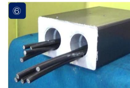
DSモルタル充填完了です。後は通常手順で止水材ストバックを充填します。
