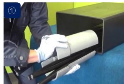
CRKの継目全体に接着剤を塗布し、ケーブルに被せて管路形状を構築します。CRKは両端部をステンレスバンドで締めて固定してください。
