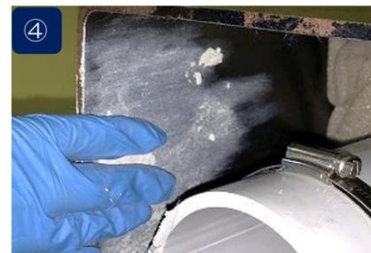
DSモルタルは、最初に開口内部の壁面とCRKの外周面にすり込むように付けてください。これにより、DSモルタルと壁面、およびCRKとの密着性が良くなります。
