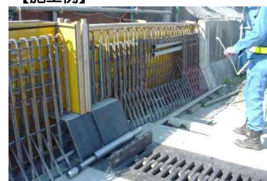
壁高欄 ジョイント部
