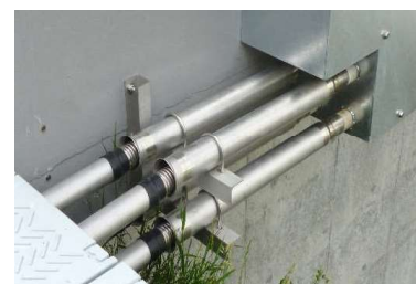
橋梁端部ボックスから土工部
