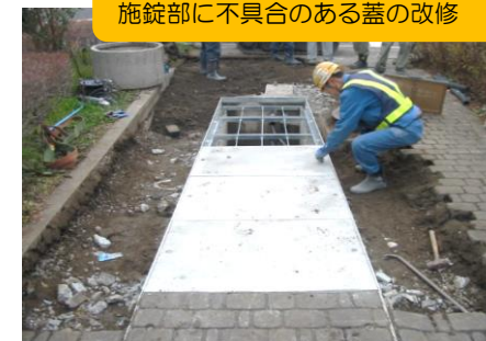
無電柱化システムの老朽化した蓋、 施錠部に不具合のある蓋の改修
