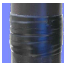
⑤アウターラップの巻き付け完了
