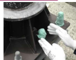
ベースプレートとボルト・ナットをCZHペーストで覆う
