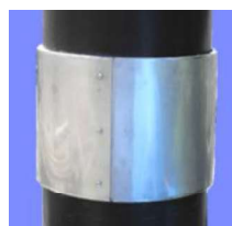
⑥ステンレス製防護カバーの取り付け完了
