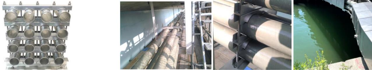
■ EP管(ステンレス製可とう電線管)
